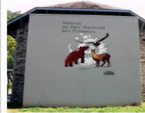
Maison du Parc national à Etsaut
